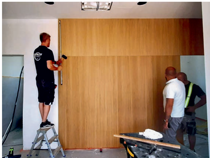
Momentka z upevňování dýhové stěny ve vstupním prostoru nové radnice
